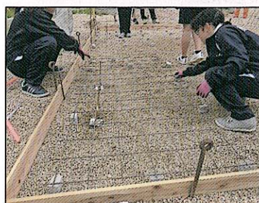
生コンクリート用の鉄筋敷設
